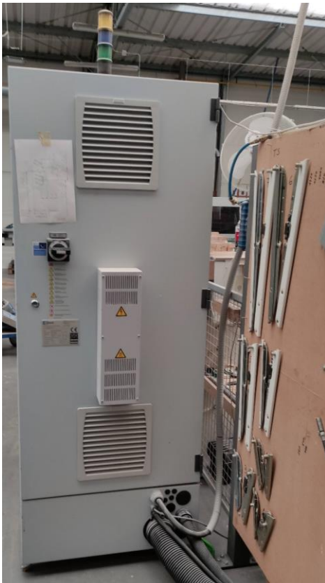
Fot. 6, 7. Tył szafy sterowniczej z wyłącznikiem zasilania
